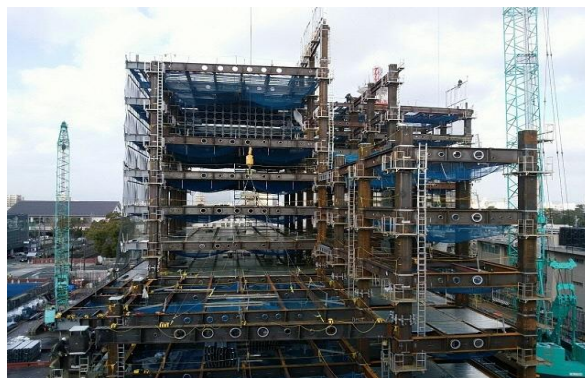
建設工事の様子 (2019年(平成31年)1月)
