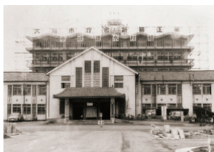
建設中の旧庁舎の後ろで
