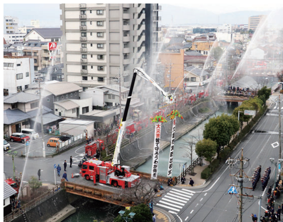
水門川沿いで行われた一斉放水
