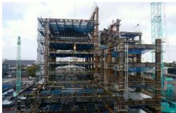
建設工事の様子 (2019年（平成31年）1月)
