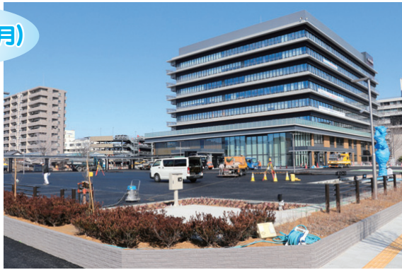
完成に向け整備が進む第1来庁者駐車場
