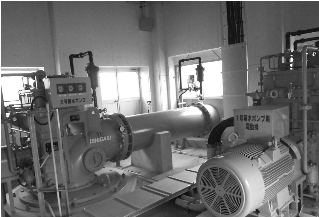
改修後の南頬排水機場
