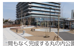
間もなく完成する丸の内公園
