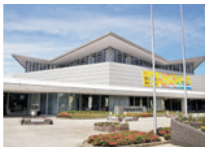
改修予定の総合体育館
