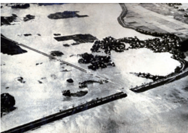
昭和27年長良川堤防決壊地 [平田町勝賀]
