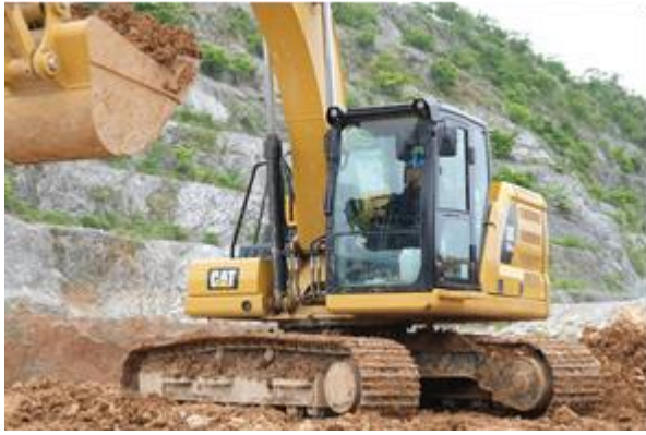
採掘現場の積込作業
