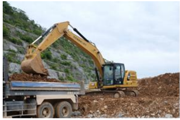
自社重機で積込作業中の若手社員
