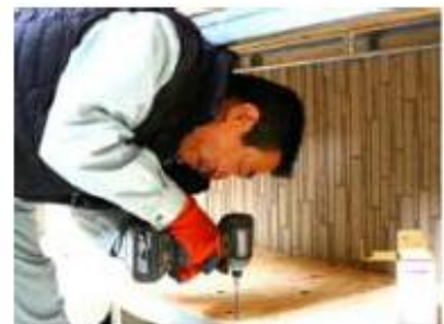
軽量工事及びボード貼工事
