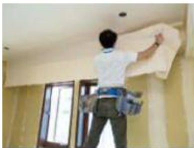
壁装工事及び カーテン・ブラインド工事
