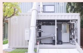
バイオマスボイラーユニット （兵庫県たつの市） 出典：櫛コンテナハウス 2040. jp
