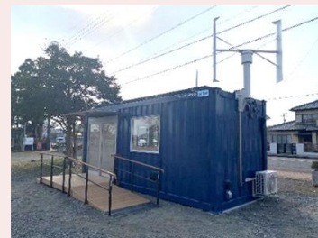
風力や太陽光による再生可能エネルギーで稼働するバス待合所
