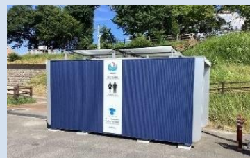
自己処理型トイレコンテナ (道の駅うきは)
