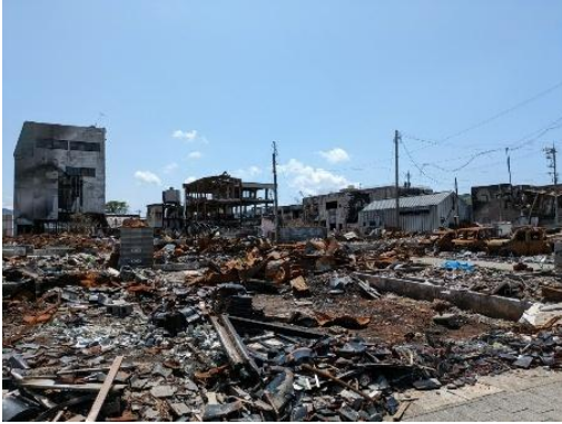
能登半島地震の被害①（朝市の火災現場）
