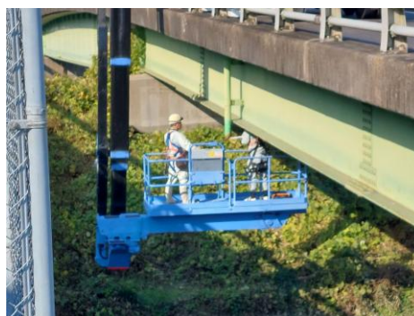
橋の点検作業（水門橋）
