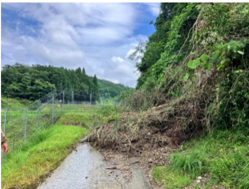
令和7年6月の大雨による土砂堆積被害（多良地区）
