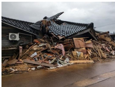
地震により倒壊する木造住宅(石川県中能登町)
