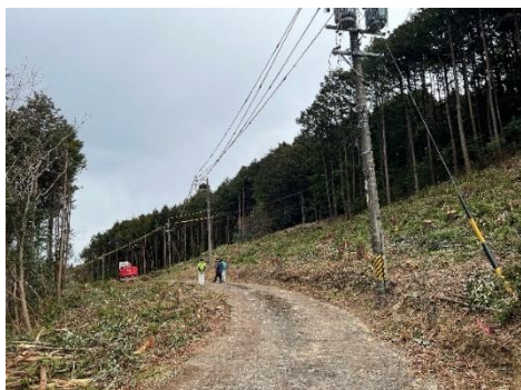
大規模停電対策 ライフライン保全対策事業(上石津町前ヶ瀬)
