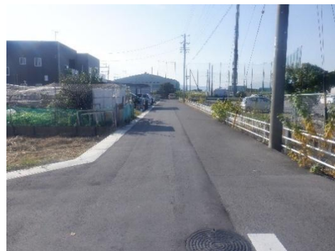
道路改良工事（大井地内）
