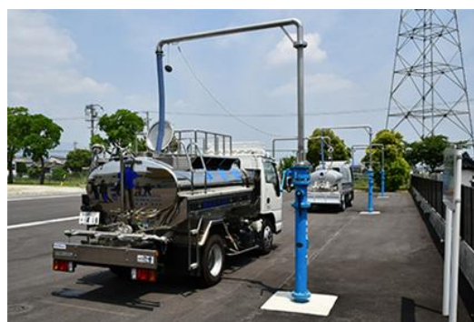
給水体制（北部水源地の応急給水栓と給水車）
