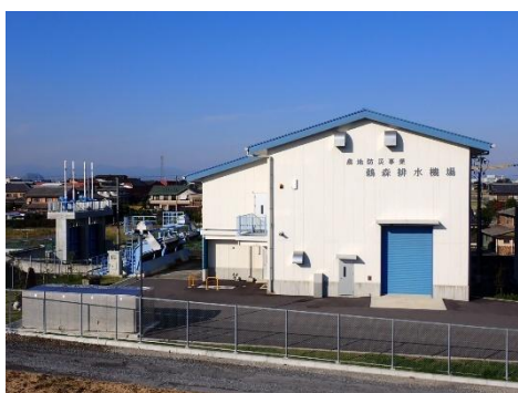
農業施設の排水機能確保（鶴森排水機場）
