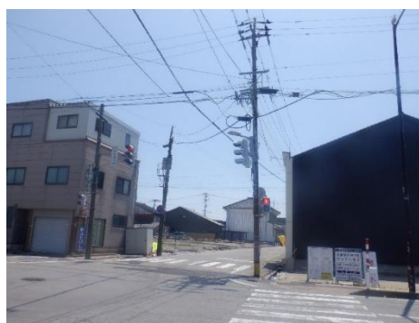
液状化による電柱の沈下
