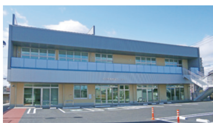
完成した東地区センター
