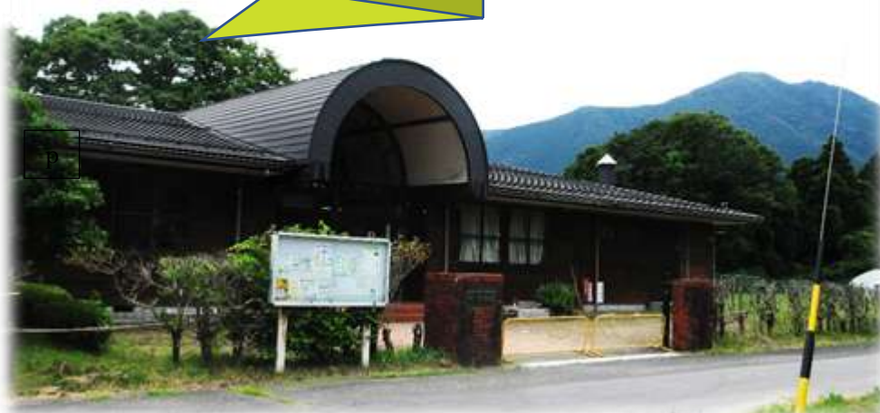
園舎外観(北側) 登降園口
