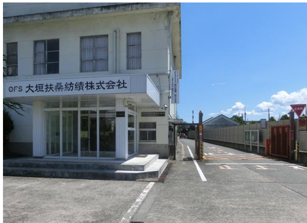
本社・大垣工場正門
