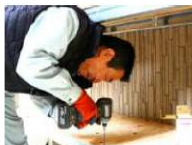
軽量工事及びボード貼工事
