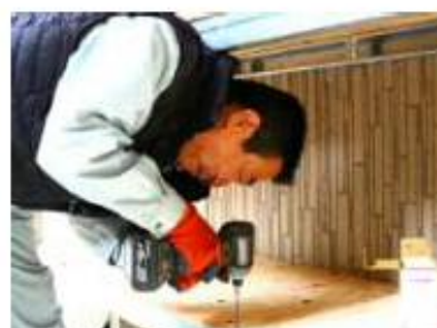
軽量工事及びボード貼工事
