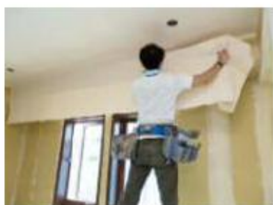
壁装工事及び カーテン・ブラインド工事
