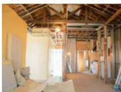
リフォーム工事
