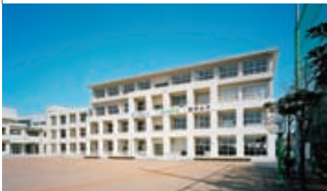
耐震化された校舎
