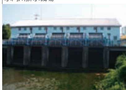
水門川排水機場
