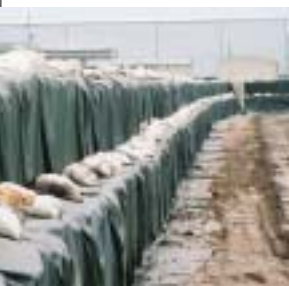
土のう積み設置工事
