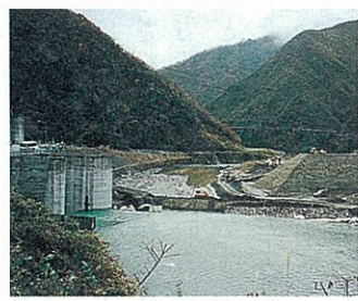
徳山ダム・仮締切り工事
