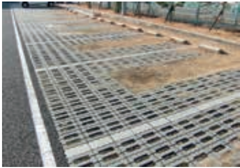
雨水浸透式舗装
