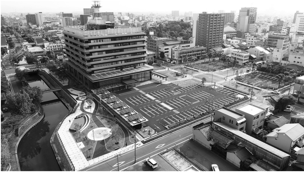
ドローンから撮影した市庁舎
