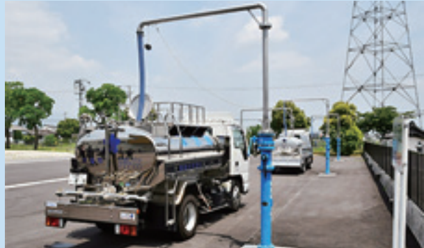
応急給水栓から給水車へ補給する様子
